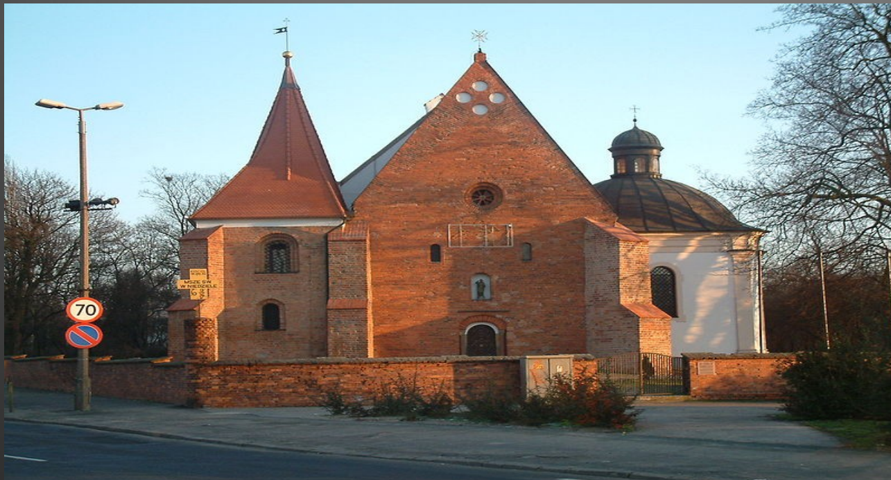
Kościół pw. św. Jana Jerozolimskiego za murami
